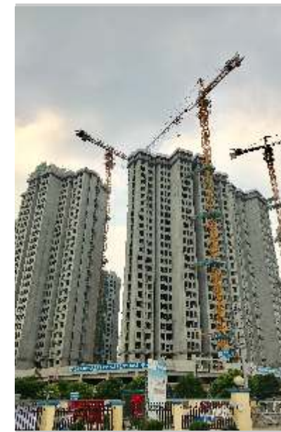
装配式建筑工程——锦丰新城
