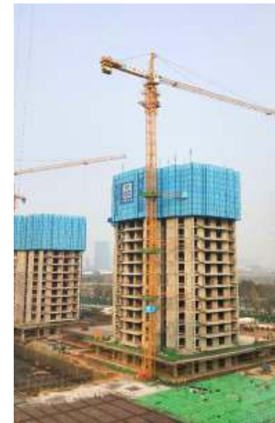
房屋建筑工程——丛树家园
