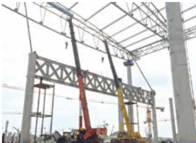
面积小,转移方便,胎架上施工走道拆除、重新组合可快速完成。施工时,现场布置三组胎架同时进行三榀梭形桁架的拼装,大大提升了施工效率。施工时两个展馆实际施工工期仅为40天。
