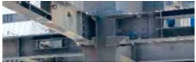
图7 隐式框架无隔板梁柱刚接连接节点
