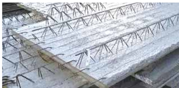
图八 叠合板出筋向上弯折
