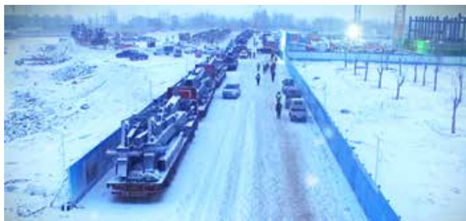
敦煌项目施工过程中面临恶劣的气候条件
