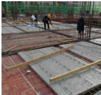
图二 叠合板底板支撑
