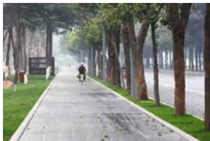
成都市三环路扩能提升工程
