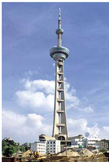
南京电视塔 整体预应力施工及钢桅杆提升
