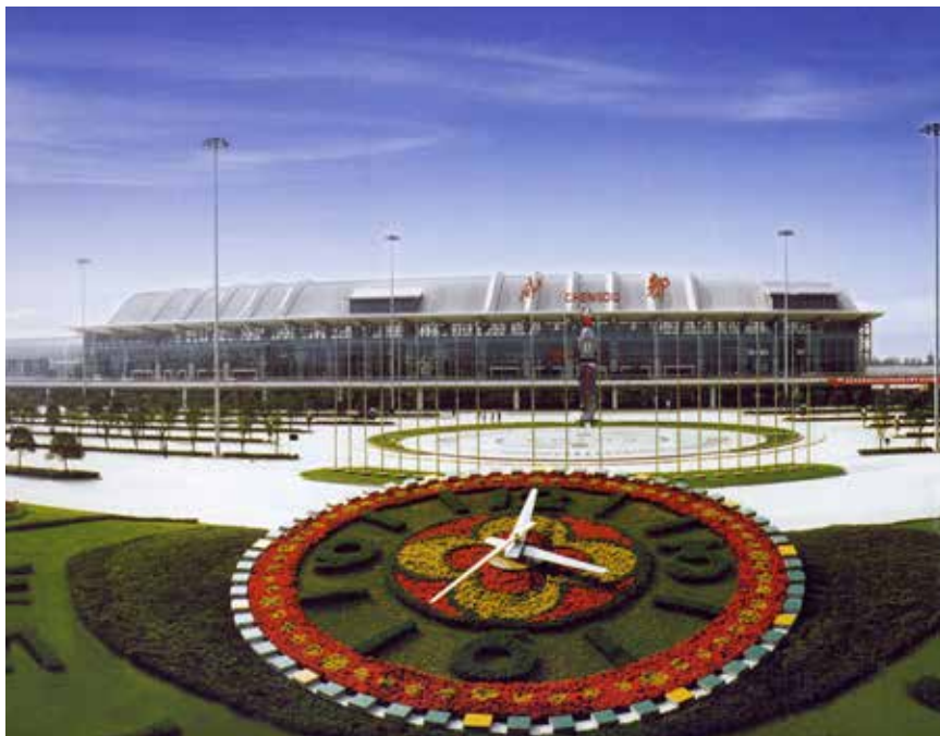
双流机场预应力工程
