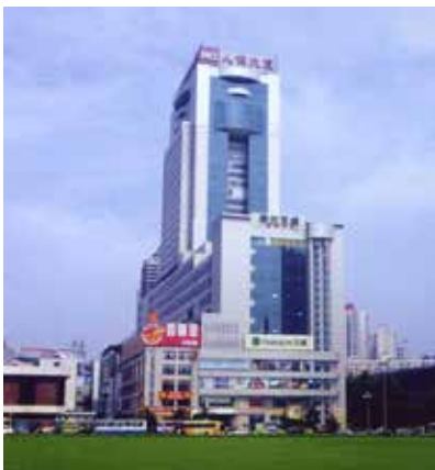
成都海发大厦扁锚变角预应力工程
