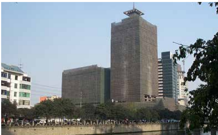
四川省发展大厦改造加固（托梁拔柱）
