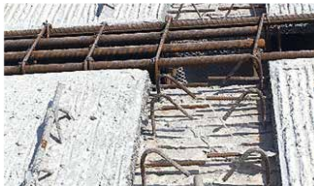
图三 叠合板与叠合梁现场配套使用
