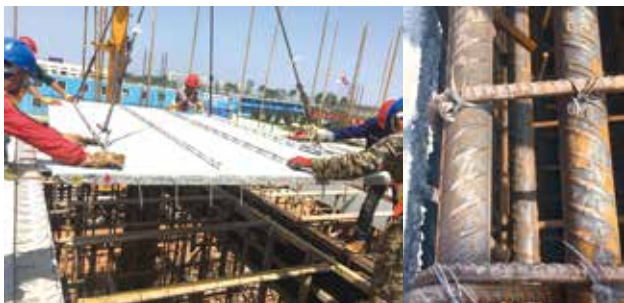
图四 叠合板出筋弯折吊装
