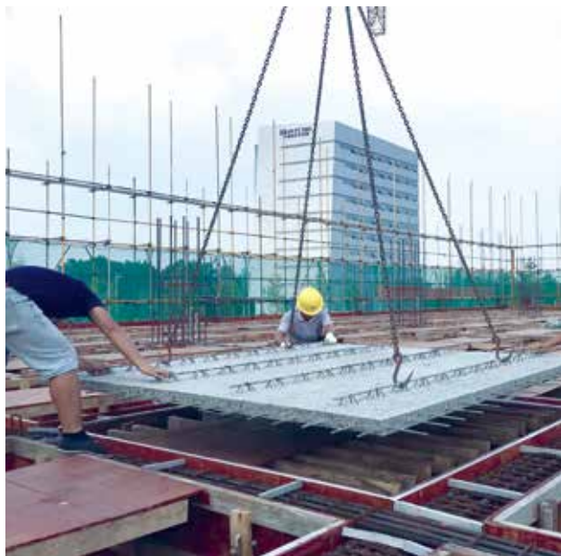
图五 梁上部筋后绑工艺示意
