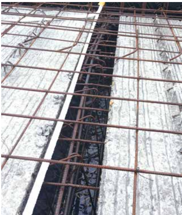
图五 梁上部筋后绑工艺示意
