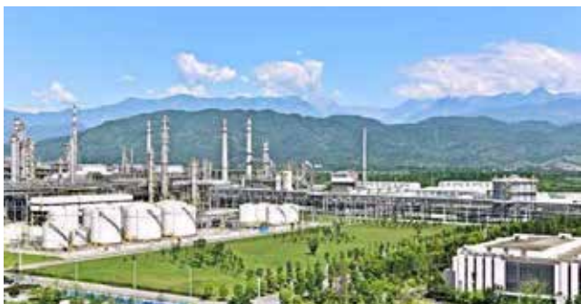
四川彭州石化项目
