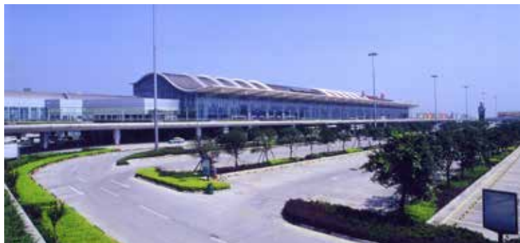
双流机场预应力工程
