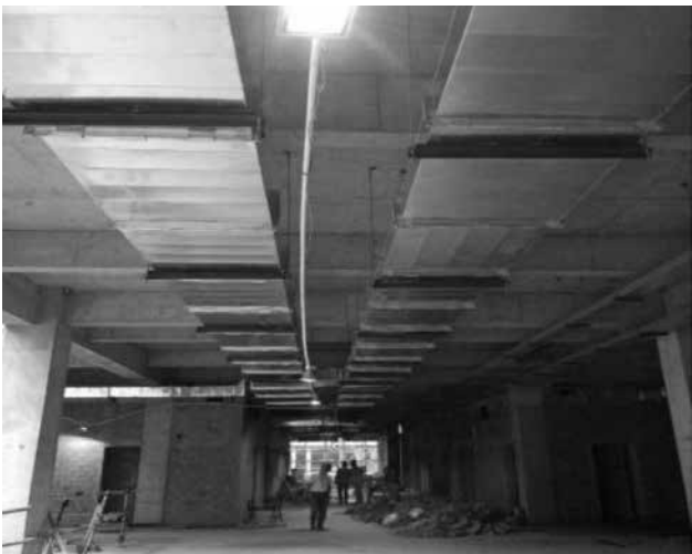
图示 10 放样区域风管桥架安装完成后
