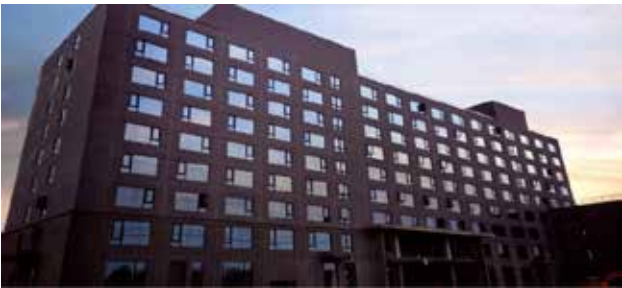
图 1 酒店外立面 Picture1 Hotel facade
