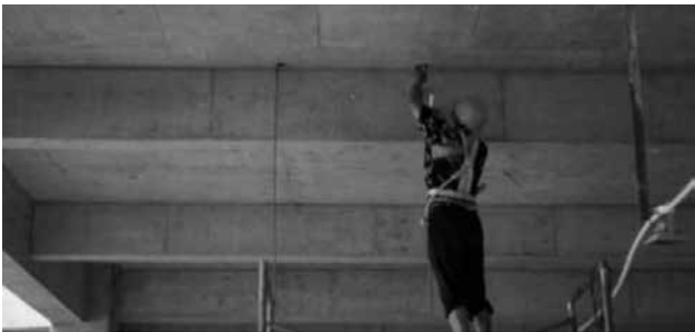
图示 8 根据放样点打吊杆
