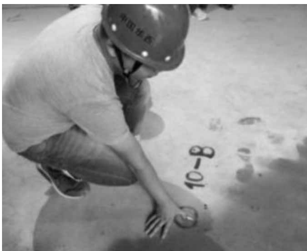
图示 4 确认第二个控制点位置
