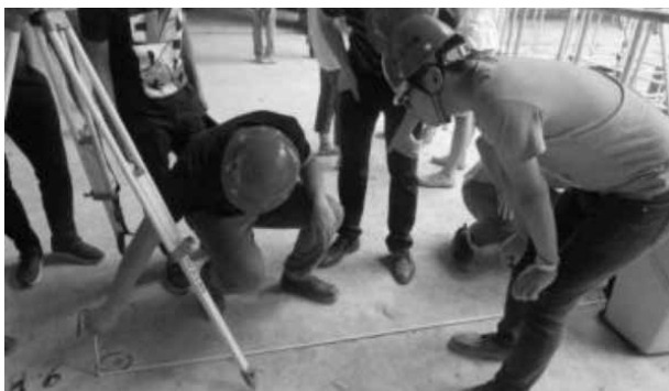
图示 2 测量控制点
