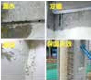
图 2 防水密封胶失效对装配式建筑的影响
