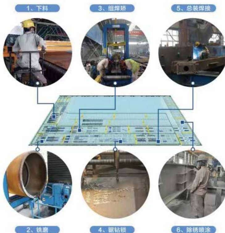
④ 钢结构智生产线
